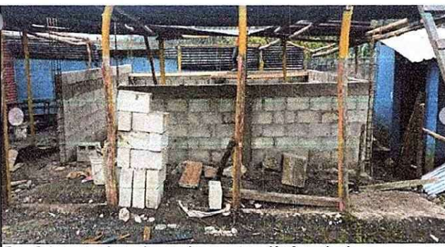
Foto 5: Levantamiento de paredes construcción formal aula.
