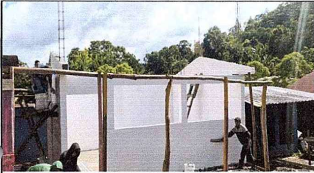
Foto 7: cernido de paredes con monocapa.
