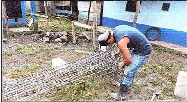
Foto 2: Armado de columnas para colocación de zapatas y fundición de solera de humedad.
