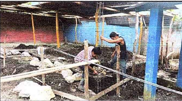
Foto 3: colocación de 9 columnas como refuerzo para inicio de levantamiento de paredes.
