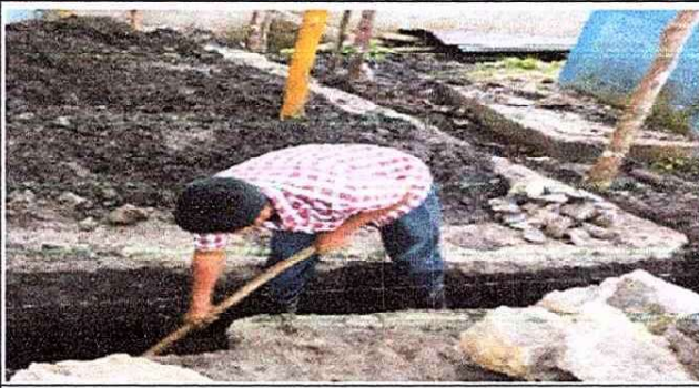
Foto 1: zanqueo para cimentación de bases con piedra, arena, cemento y hierro.
