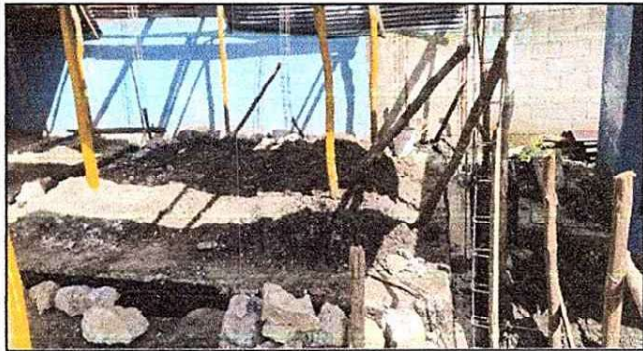
Foto 4: Instalación de 8 columnas para refuerzo construcción aula.
