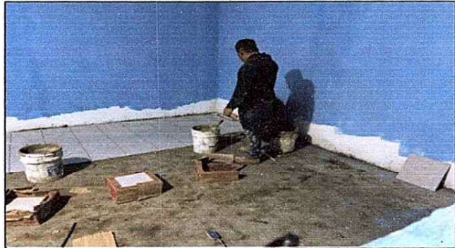
Foto 8: Instalación de piso ceramico interior aula.
